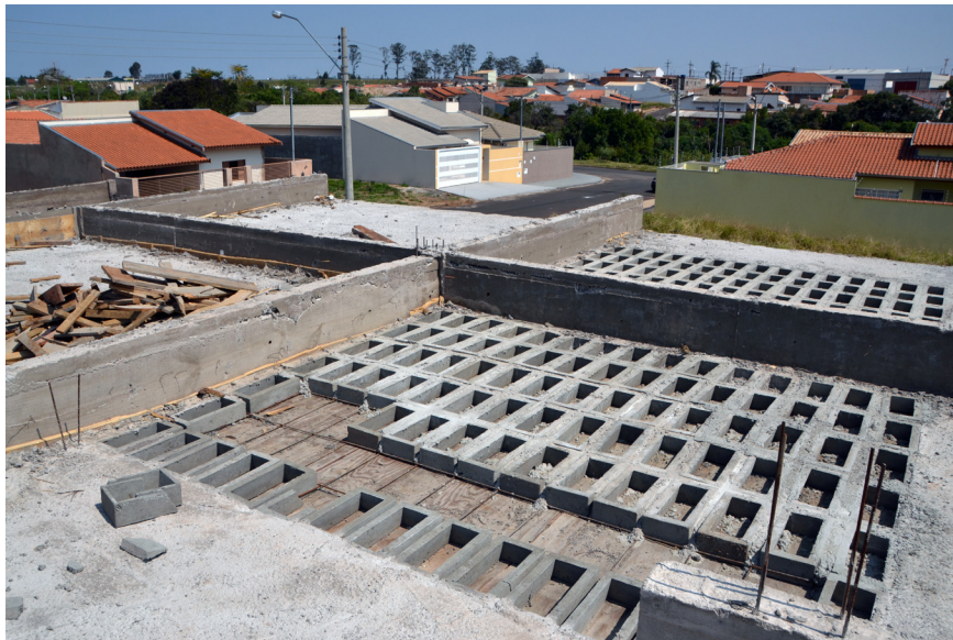
fotos de obra | pré-fabricação e instalação dos elementos vazados
